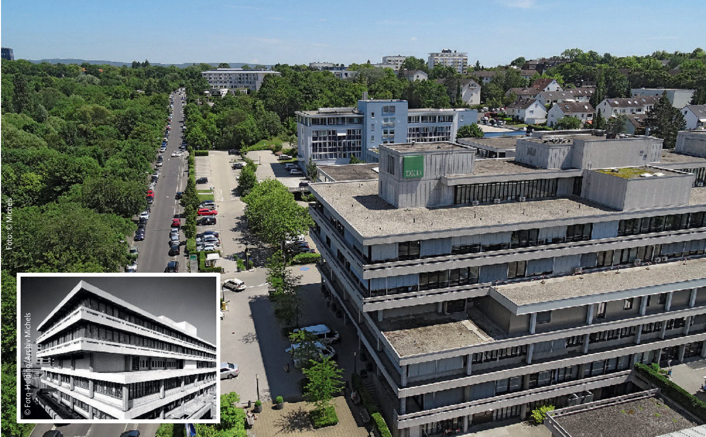
Das kleine Foto des fertigen Rohbaus der Deutschen Klinik für Diagnostik (DKD) in Wiesbaden aus dem Jahr 1969 zeigt die Besonderheit des Säulenprinzips (Architekturbüro Braun und Schlockermann). Die Farbaufnahme bietet den Blick auf die DKD heute vom Penthouse des benachbarten Hotels aus.
